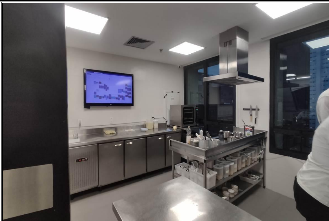
CONJUNTO 111 – COZINHA INDUSTRIAL
