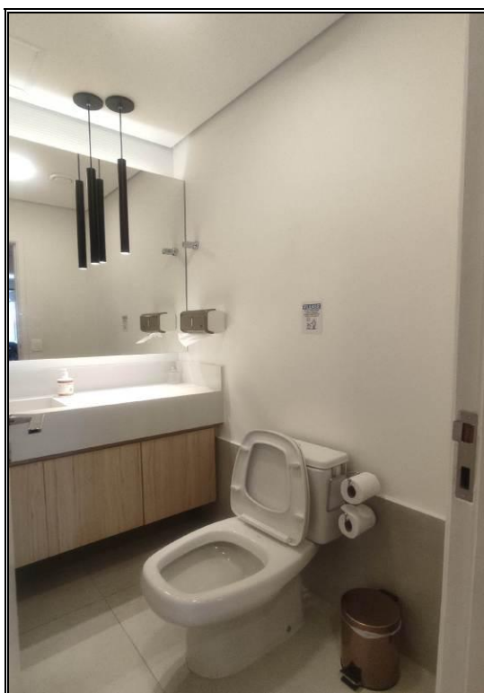
CONJUNTOS 45 E 46 – SANITÁRIO
