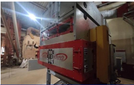
Medianeira Troca de máquina de limpeza concluída
