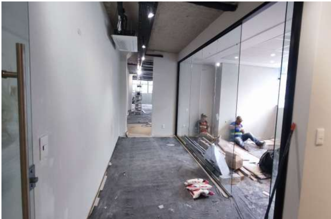
Conjunto 82 – Reforma em fase de conclusão
