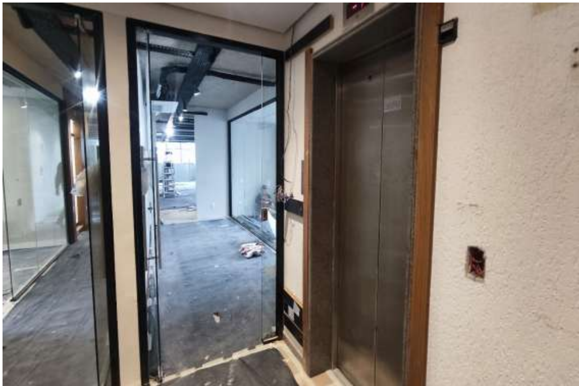
Conjunto 82 – Reforma em fase de conclusão
