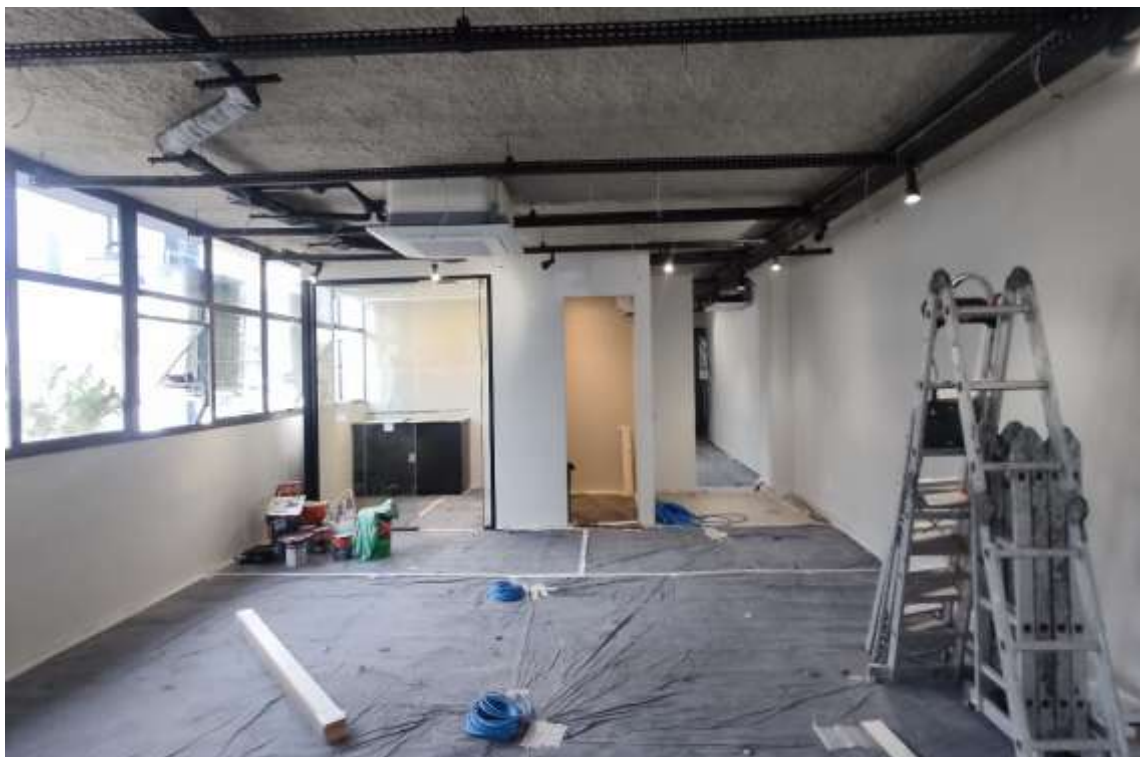
Conjunto 82 – Reforma em fase de conclusão
