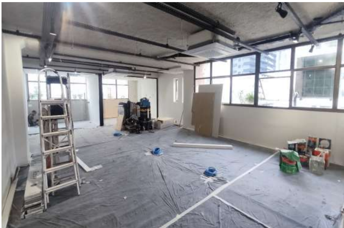
Conjunto 82 – Reforma em fase de conclusão
