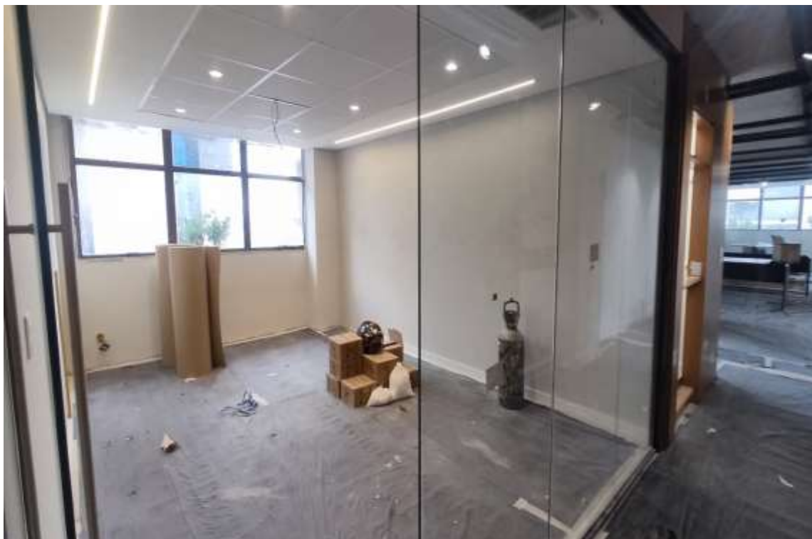
Conjunto 81 – Reforma em fase de conclusão
