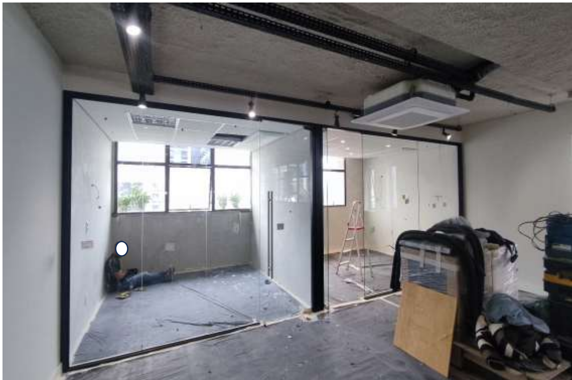
Conjunto 82 – Reforma em fase de conclusão
