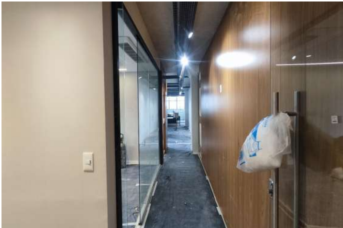
Conjunto 81 – Reforma em fase de conclusão
