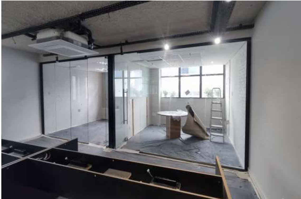
Conjunto 81 – Reforma em fase de conclusão
