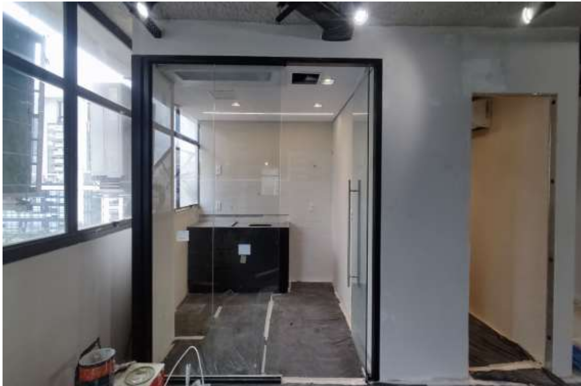
Conjunto 82 – Reforma em fase de conclusão
