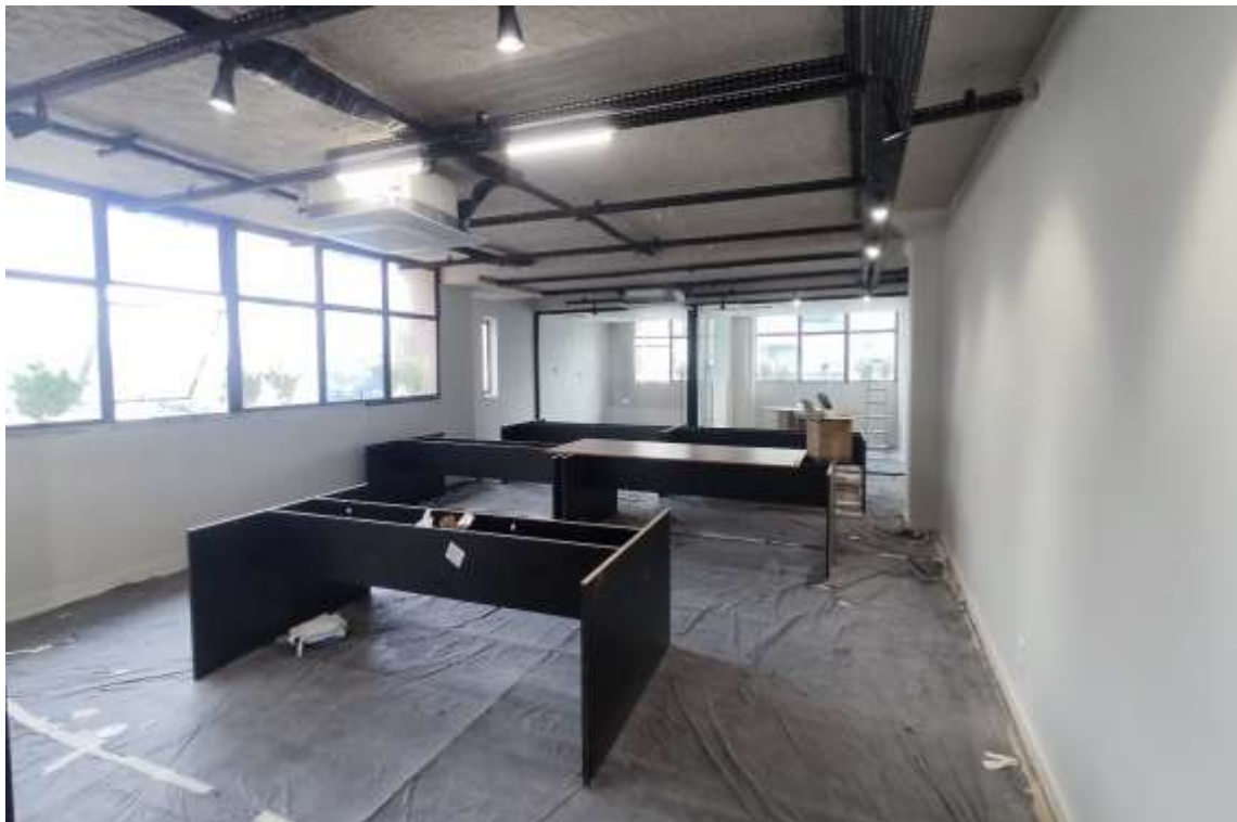
Conjunto 81 – Reforma em fase de conclusão
