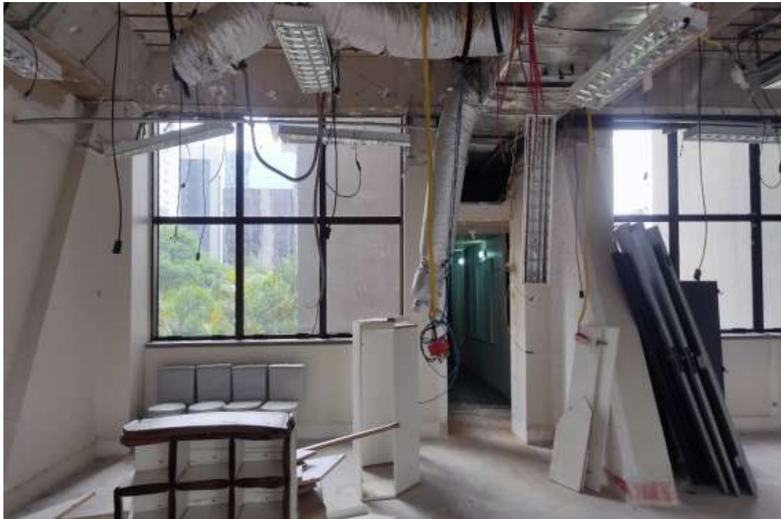
Conjuntos 53 e 54 – Em reforma
