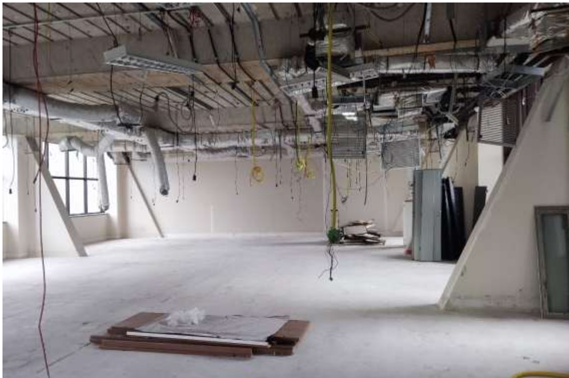
Conjuntos 53 e 54 – Em reforma
