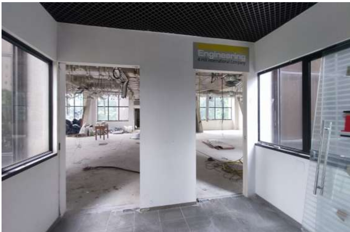
Conjuntos 53 e 54 – Acesso a Unidade
