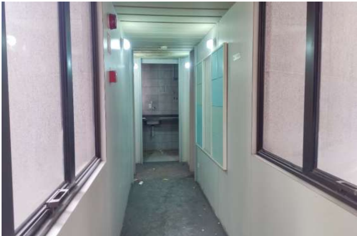
Conjuntos 53 e 54 – Em reforma
