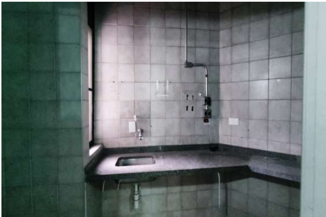
Conjuntos 53 e 54 – Em reforma
