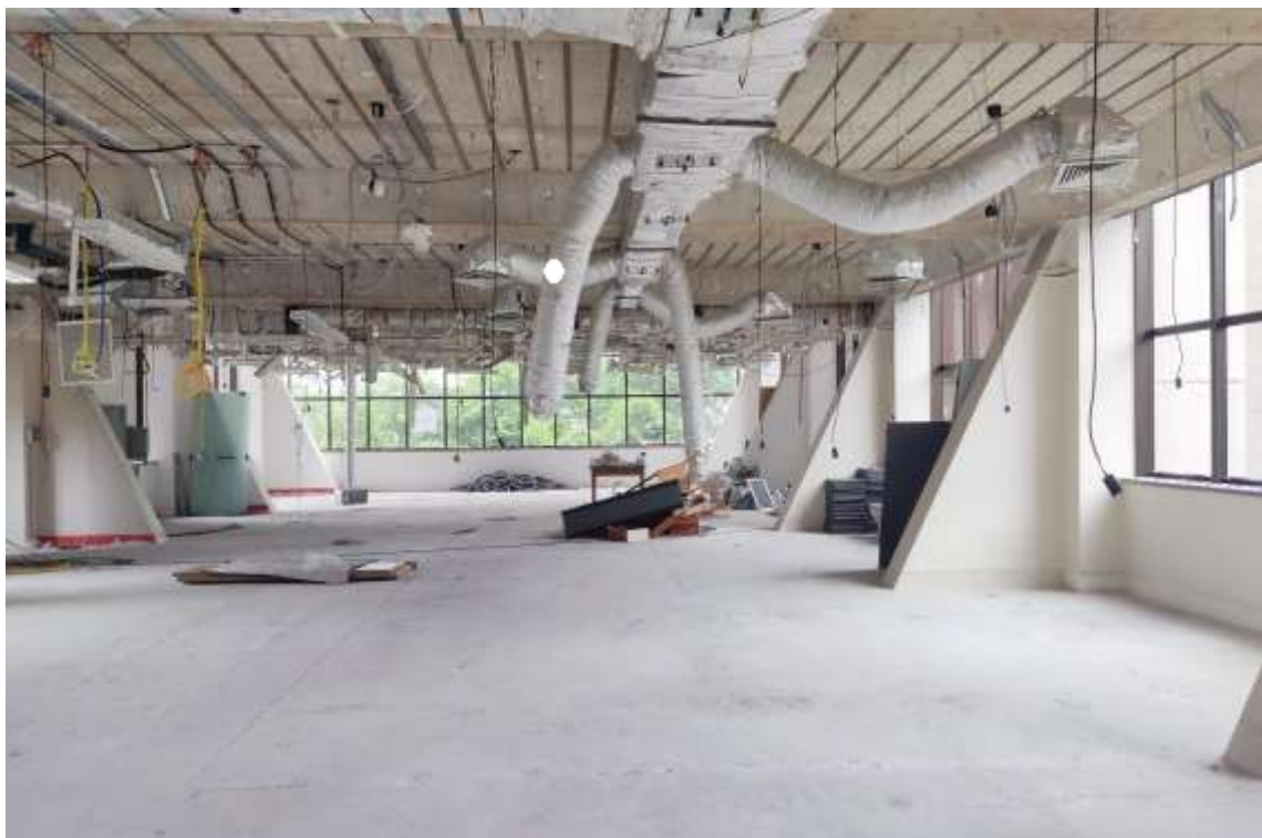
Conjuntos 53 e 54 – Em reforma
