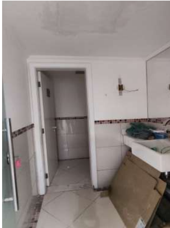
Reforma em fase de conclusão
