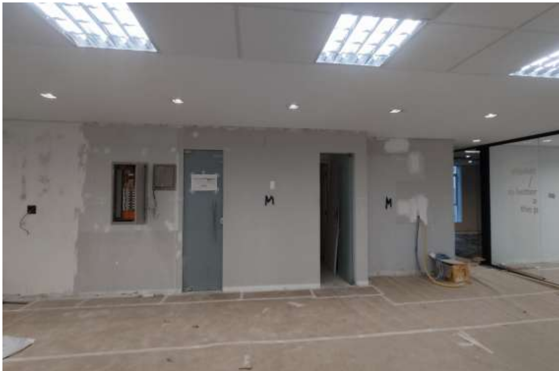
Reforma em fase de conclusão
