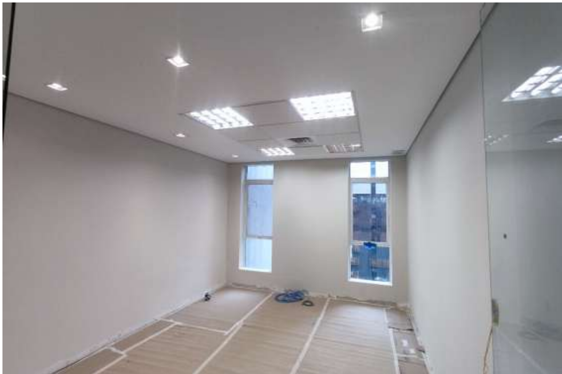
Reforma em fase de conclusão
