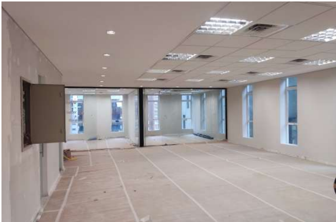
Reforma em fase de conclusão
