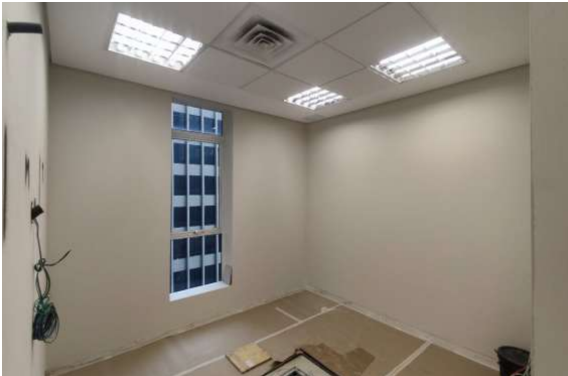
Reforma em fase de conclusão
