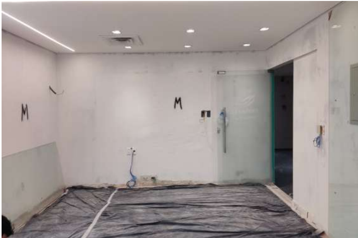
Reforma em fase de conclusão
