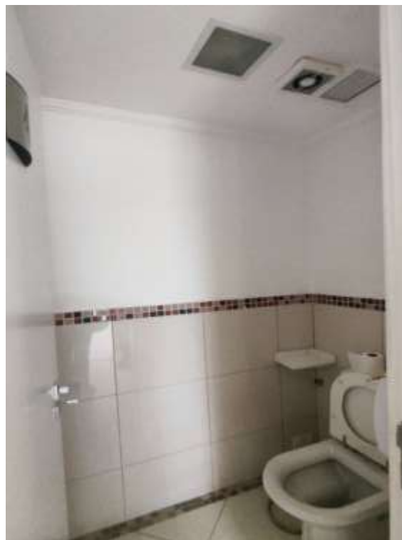
Reforma em fase de conclusão
