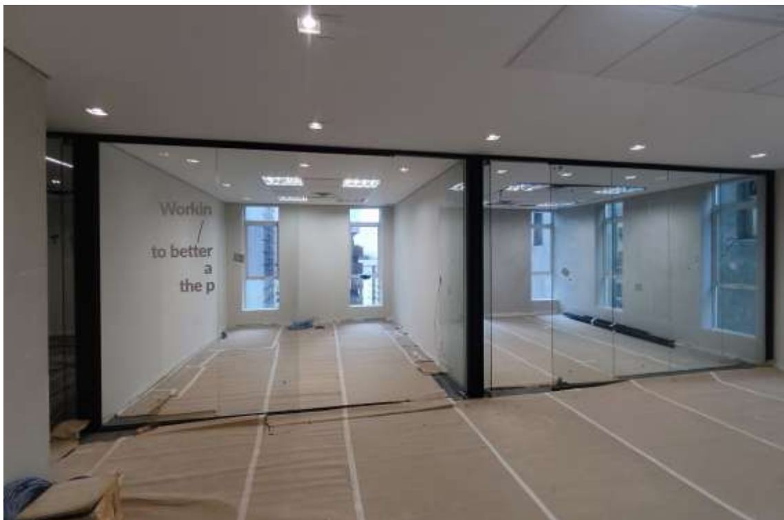
Reforma em fase de conclusão
