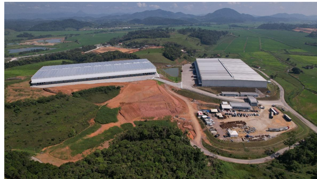
Construção Nave 2 – Foto Panorâmica
