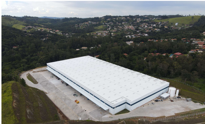
Imagem 2: Foto aérea do galpão
