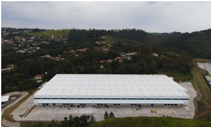
Imagem 1: Foto aérea do galpão
