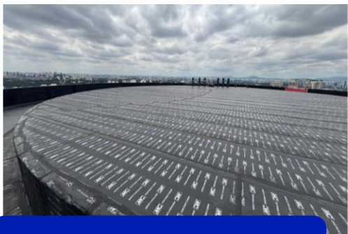
Superfície do heliponto após aplicação da manta de impermeabilização
