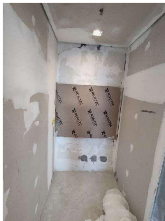
CONJUNTOS 153 AO 155 – SANITÁRIO- PAVIMENTO SUPERIOR
