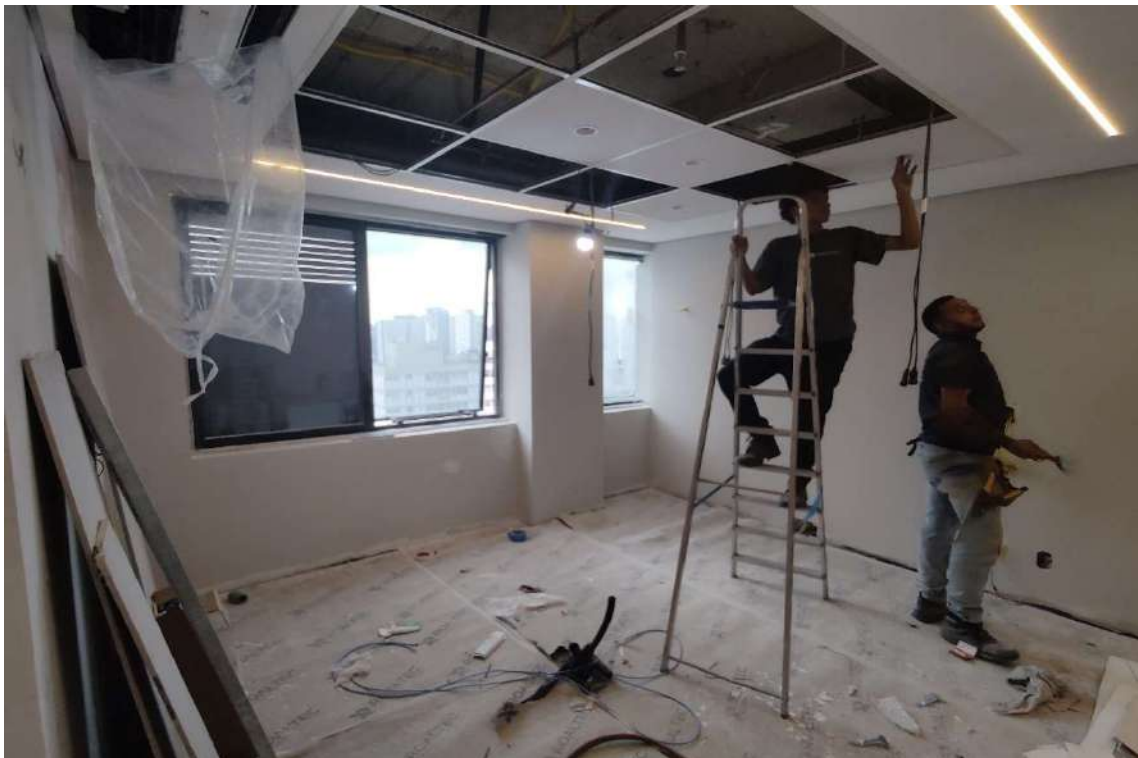
CONJUNTOS 153 AO 155 – SALA- PAVIMENTO INFERIOR
