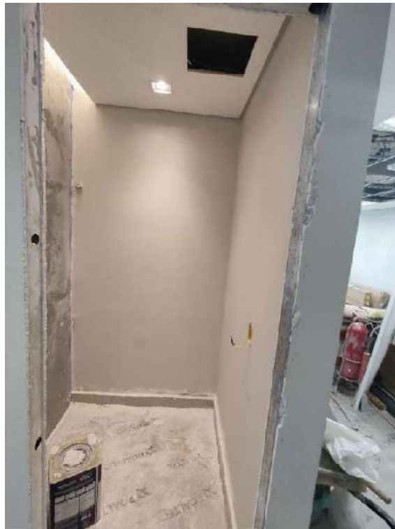
CONJUNTOS 153 AO 155 – SANITÁRIO- PAVIMENTO INFERIOR
