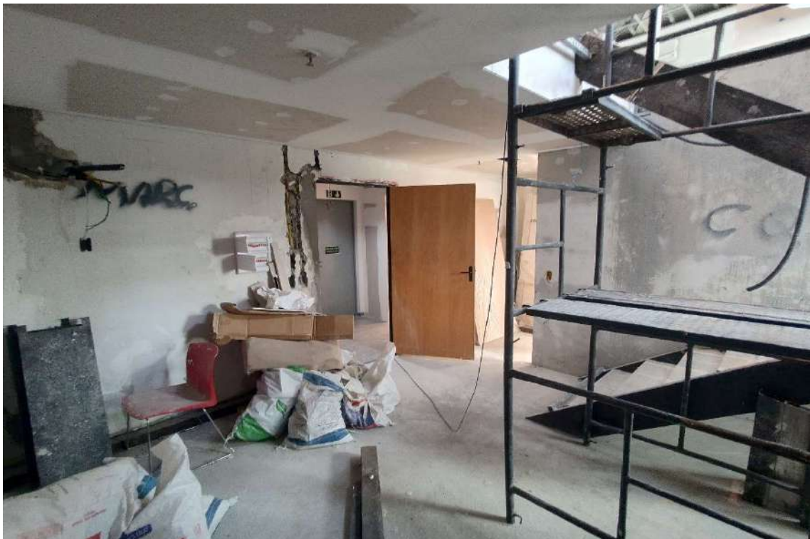
CONJUNTOS 153 AO155 – ACESSO AO PAVIMENTO SUPERIOR
