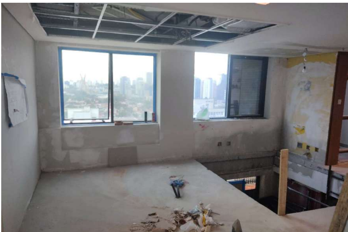
CONJUNTOS 153 AO 155 –HALL DE ACESSO PRINCIPAL
