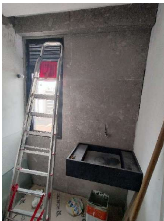
CONJUNTOS 153 AO155 – SANITÁRIO -PAVIMENTO INFERIOR
