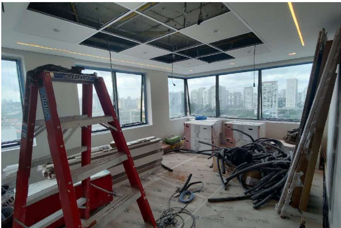
CONJUNTOS 153 AO 155 – SALA- PAVIMENTO INFERIOR
