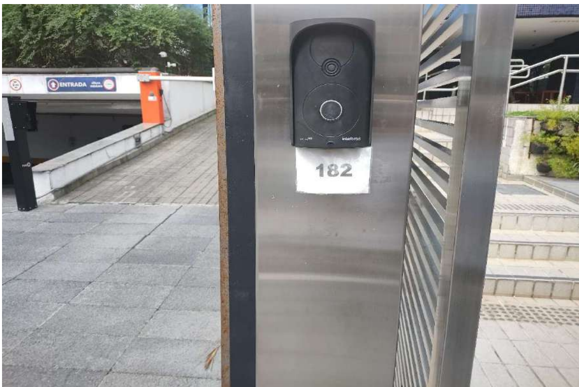
IDENTIFICAÇÃO DO EDIFÍCIO – ÁREA EXTERNA
