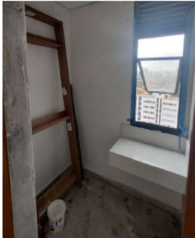
CONJUNTOS 153 AO 155 – SANITÁRIO- PAVIMENTO SUPERIOR
