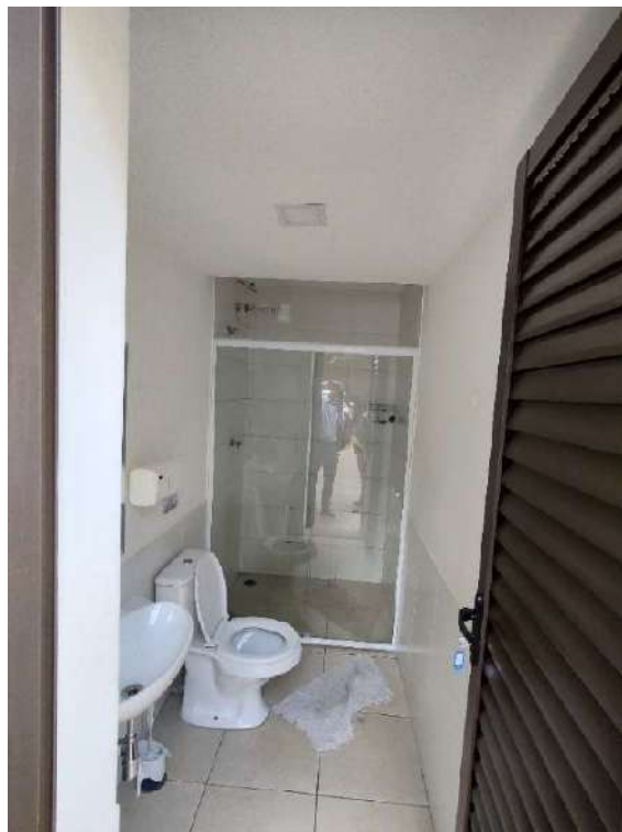
SANITÁRIO – ÁREA COMUM TÉRREO
