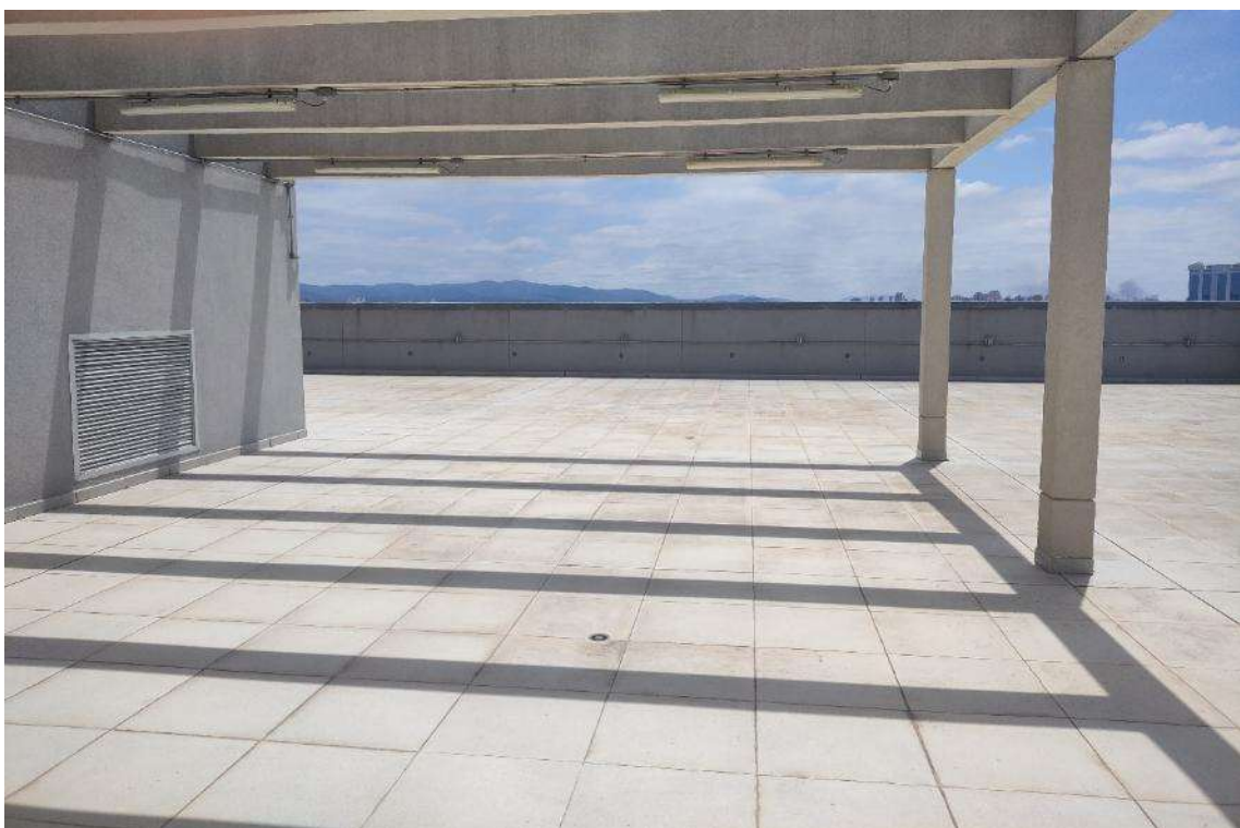
COBERTURA -PAVIMENTO SUPERIOR – CONJUNTO N° 1801
