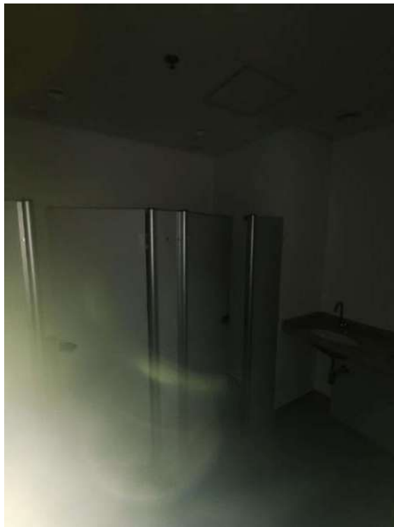
SANITÁRIO – PAVIMENTO INFERIOR- CONJUNTO Nº 1804
