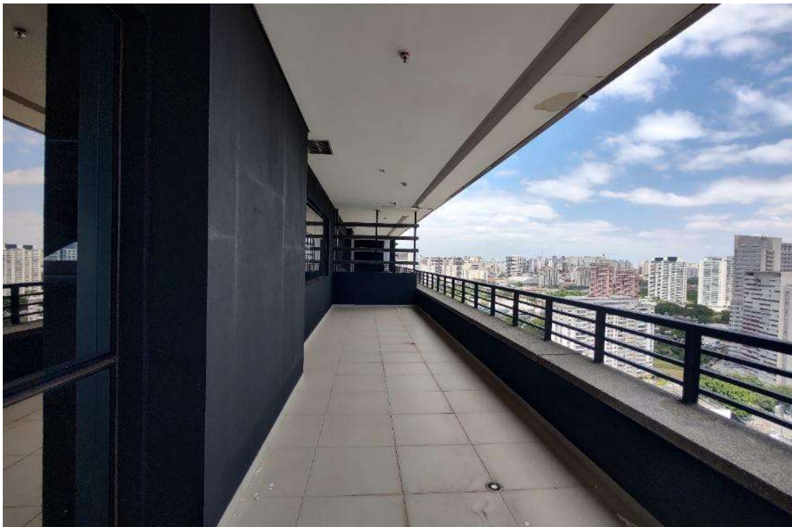
VARANDA – PAVIMENTO INFERIOR – CONJUNTO Nº 1804
