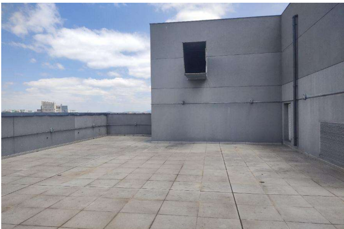
COBERTURA PAVIMENTO SUPERIOR – CONJUNTO Nº 1804
