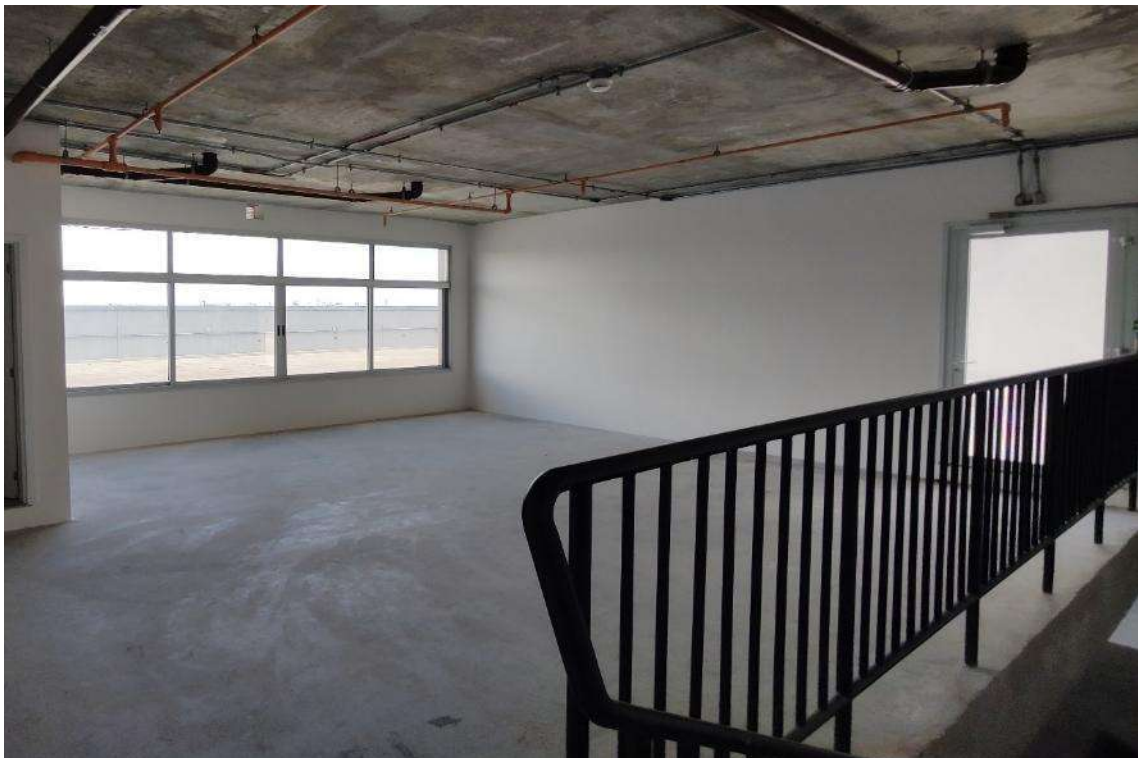
HALL PAVIMENTO SUPERIOR CONJUNTO Nº 1804
