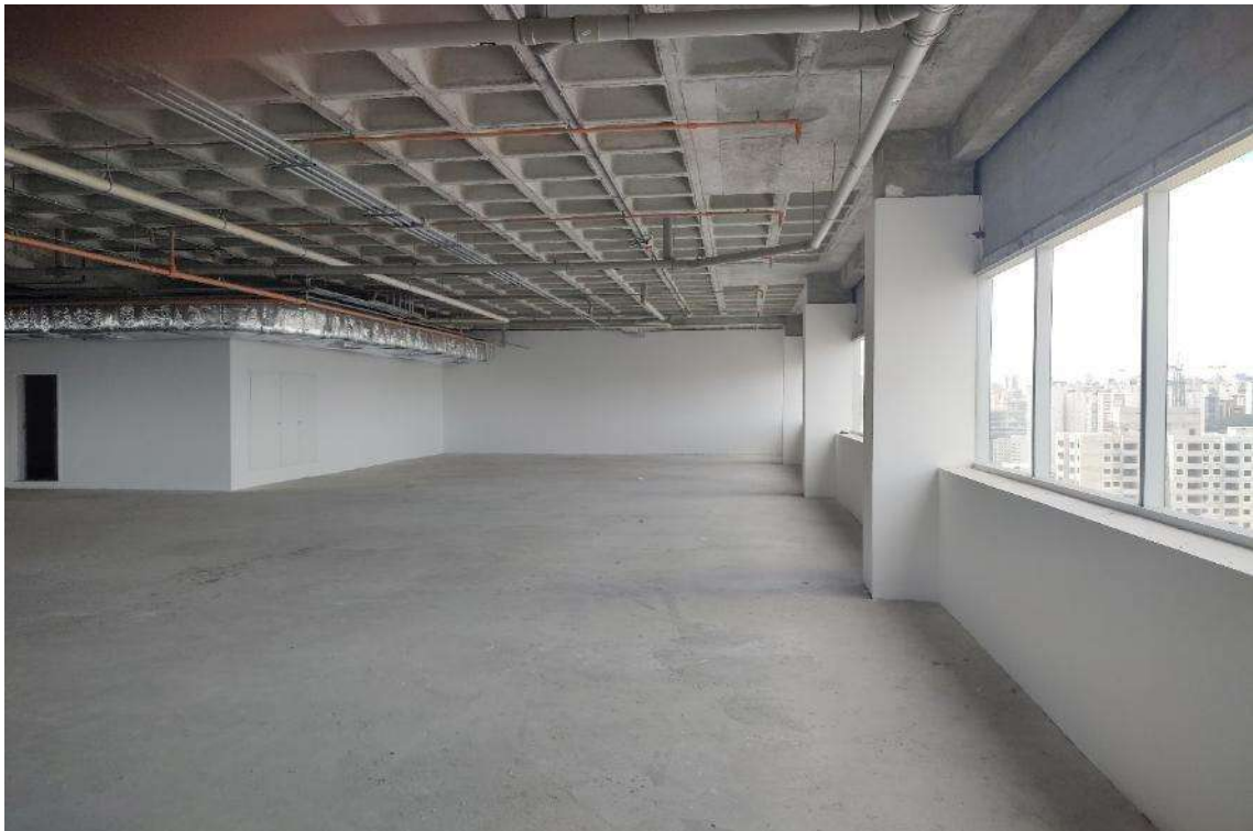
SALÃO (FUTURA ESTAÇÃO DE TRABALHO) – PAVIMENTO INFERIOR- CONJUNTO N° 1804
