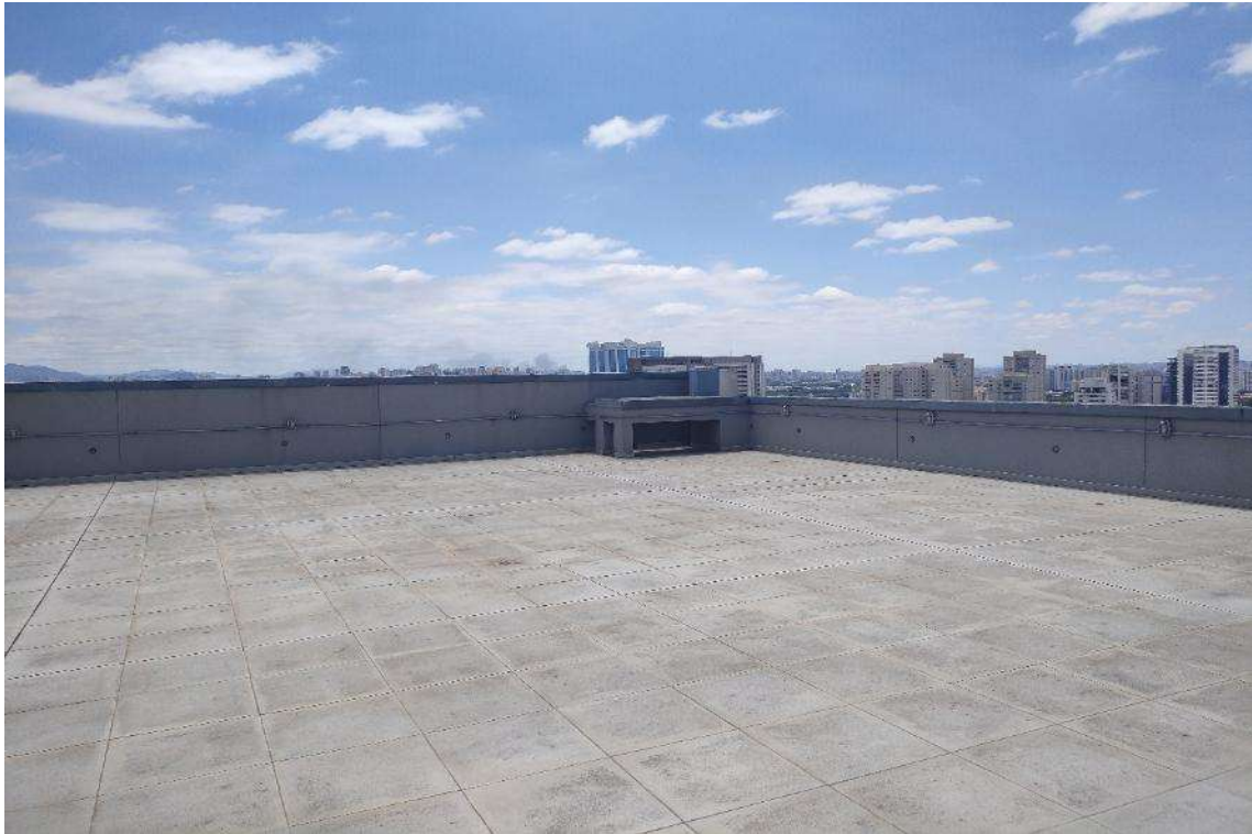
COBERTURA PAVIMENTO SUPERIOR – CONJUNTO Nº 1804
