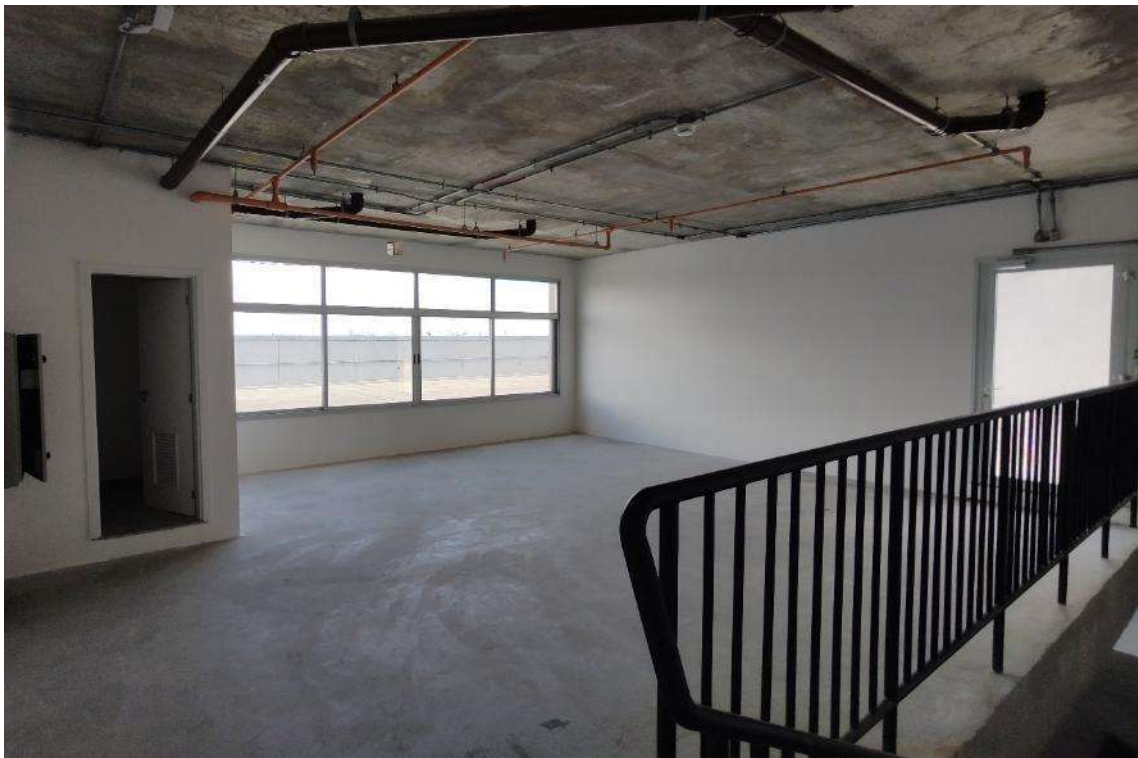
HALL DE ACESSO PAVIMENTO SUPERIOR – CONJUNTO N° 1801
