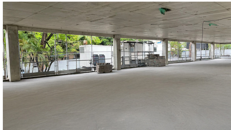
FOTO DA OBRA
