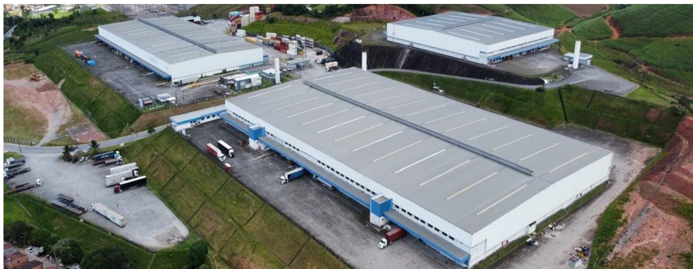
Imagem 1: Foto Aérea do Imóvel
