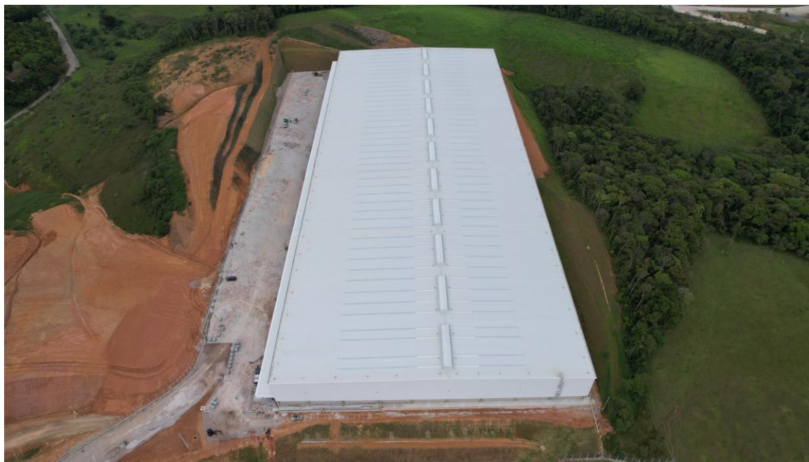
Construção Nave 2 – Foto Panorâmica
