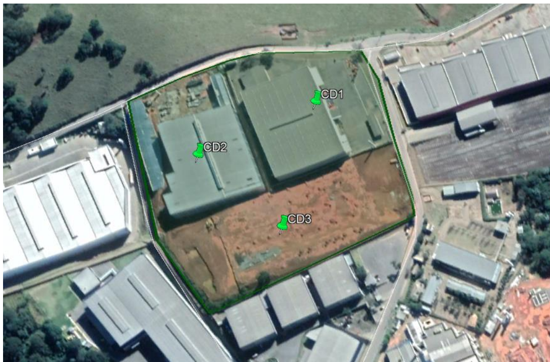
FOTOGRAFIA AÉREA DO CONDOMÍNIO LOGÍSTICO 3
