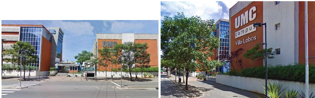
FACHADA E ACESSO PRINCIPAL – AVENIDA IMPERATRIZ LEOPOLDINA
