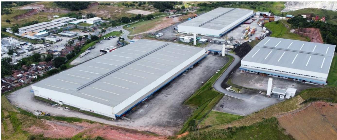
Imagem 3: Foto Aérea dos Galpões
