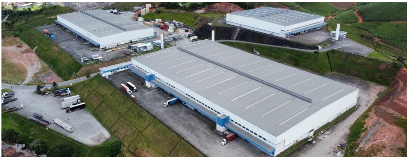
Imagem 1: Foto Aérea do Imóvel
