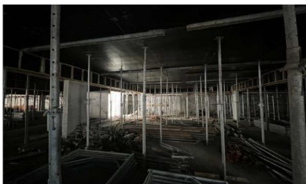
Reescoramentos 50% do subsolo
