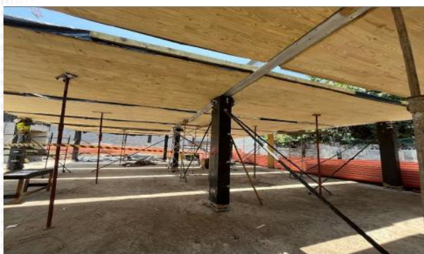
Laje em madeira
