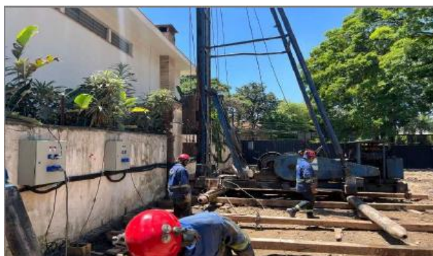
Bate estaca cravando perfis
