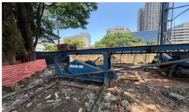
Mini bate estaca para cravação embaixo da copa das árvores
