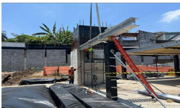
Montagem de viga metálica de intersecção entre pilar de madeira e core do elevador
