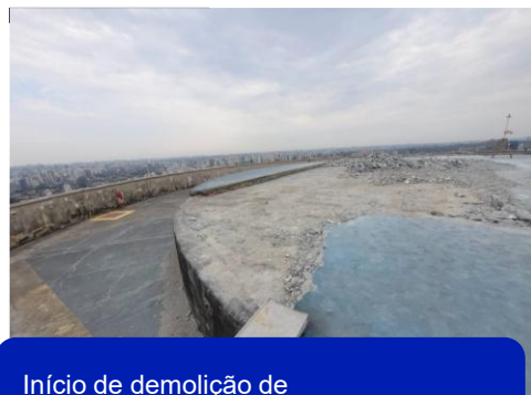
Início de demolição de impermeabilização antiga do heliponto
