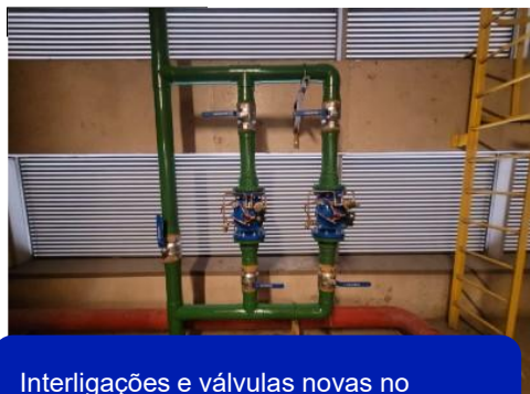
Interligações e válvulas novas no sistema de abastecimento
