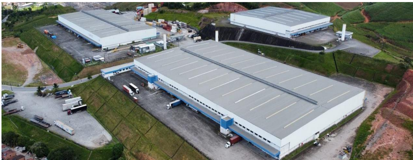
Imagem 1: Foto Aérea do Imóvel
