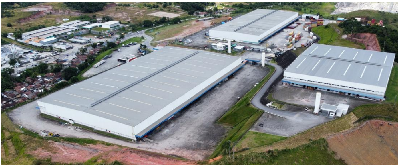
Imagem 3: Foto Aérea dos Galpões
