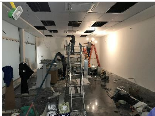
Área em reforma
