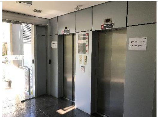
Hall de elevadores
