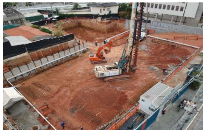
Foto da Escavação da Obra
