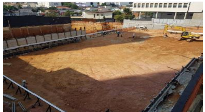
Foto da Escavação da Obra
