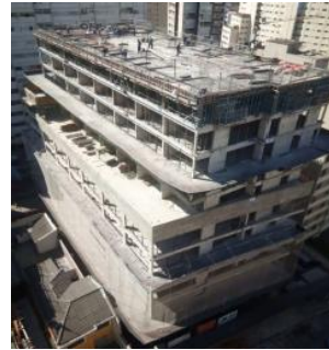
Foto Estrutura da Obra
