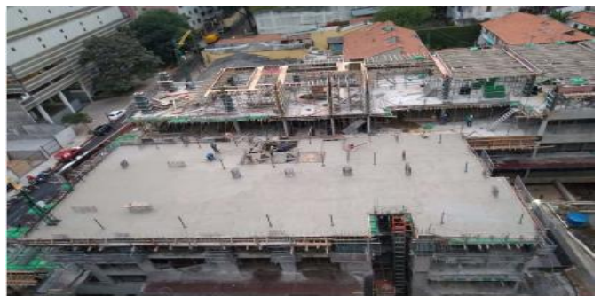
Foto Estrutura da Obra
