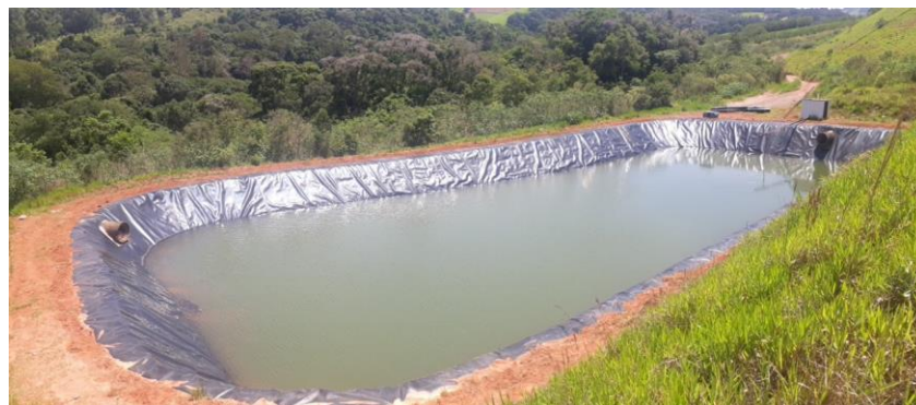
Tanque do retardo de água pluvial
