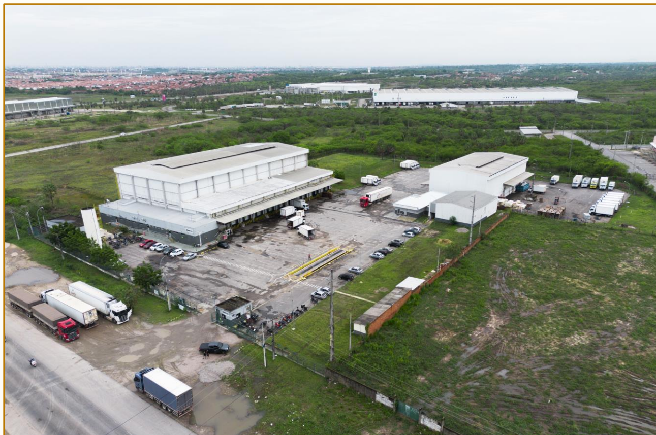
Armazém refrigerado da Comfrio Logística, localizado na Rodovia BR-020, 527, Caucaia – CE.
