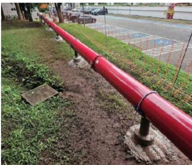
Instalação da tubulação de incêndio
