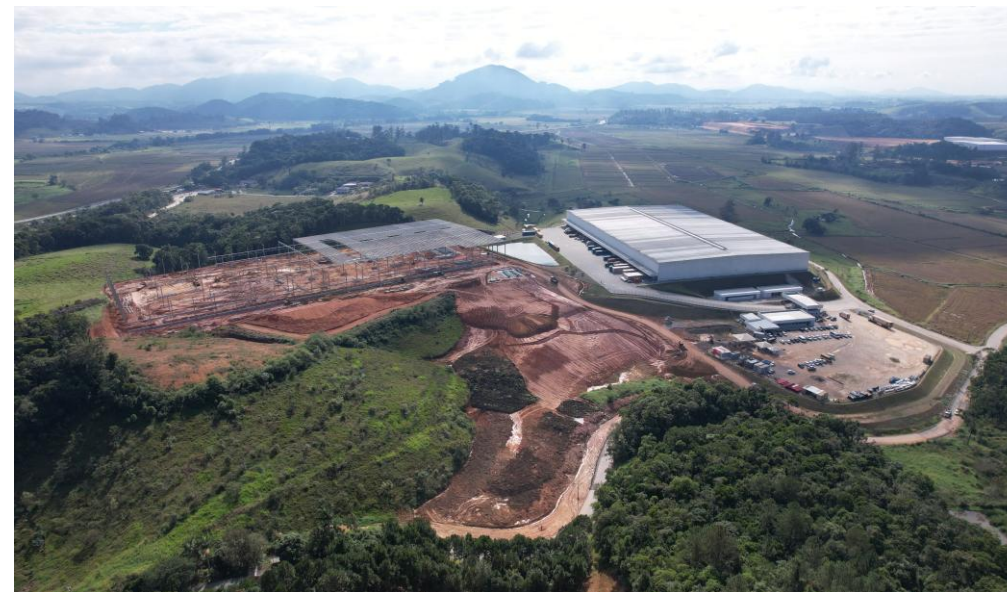
Construção Nave 2 – Foto Panorâmica
