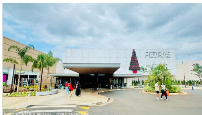
PDP | PORTARIA PEDRAS | OBRA ENTREGUE
