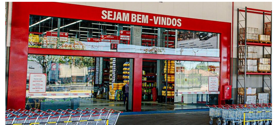
Fachada do Imóvel - Vista Frontal
