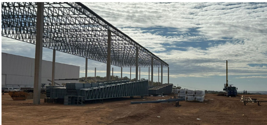
Montagem de Estruturas Metálicas
