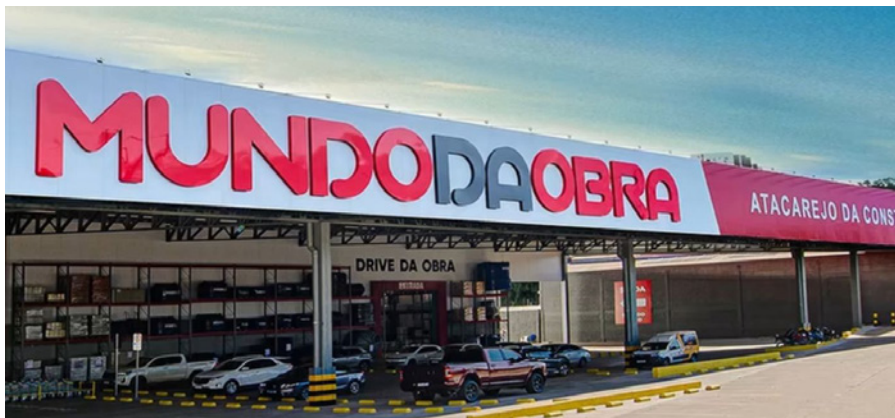
Fachada do Imóvel - Vista Externa
