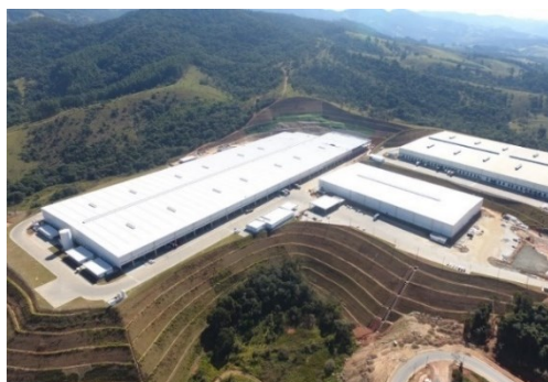
Extrema Business Park – visão aérea
