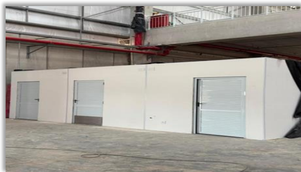
Montagem Módulos Prontos de Sanitários
