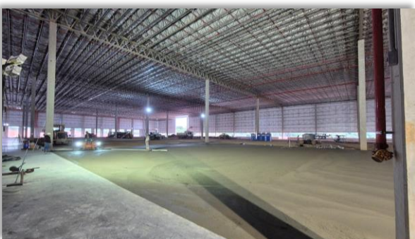
Concretagem Piso interno
