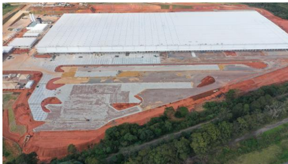
Vista Aérea - Concretagem e Preparo Caixa Externa
