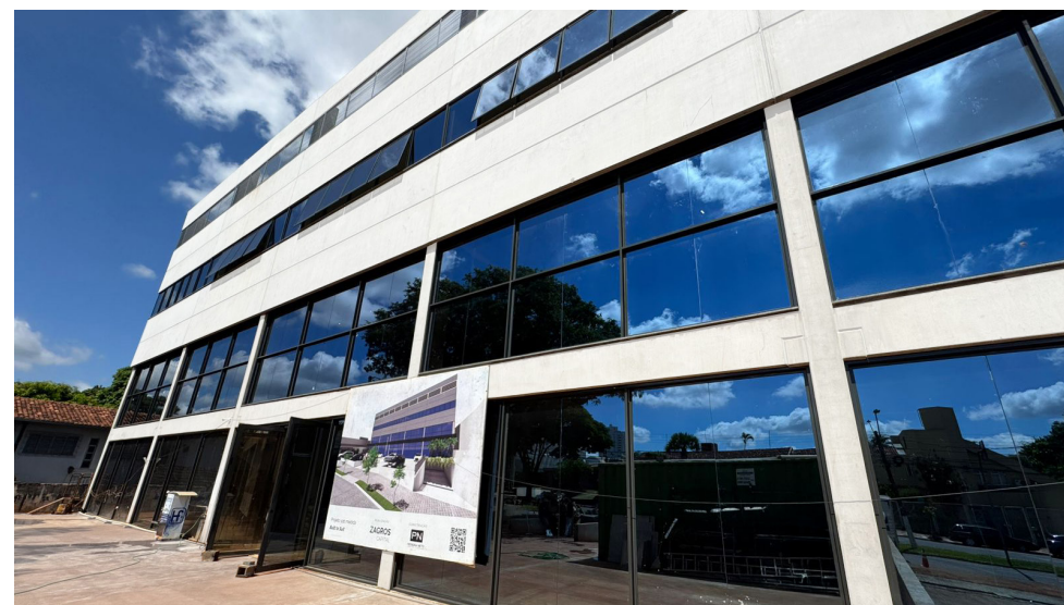
FOTO DA OBRA
