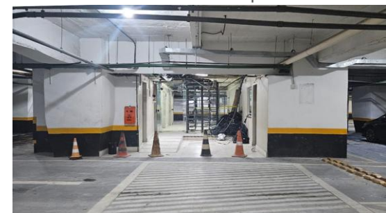
Subsolo "antes" e "depois"
