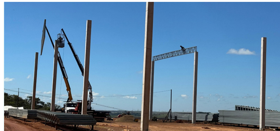
Içamento de Pilares
