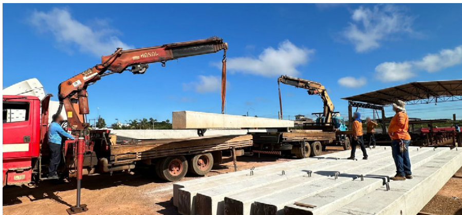
Transporte de Pilares
