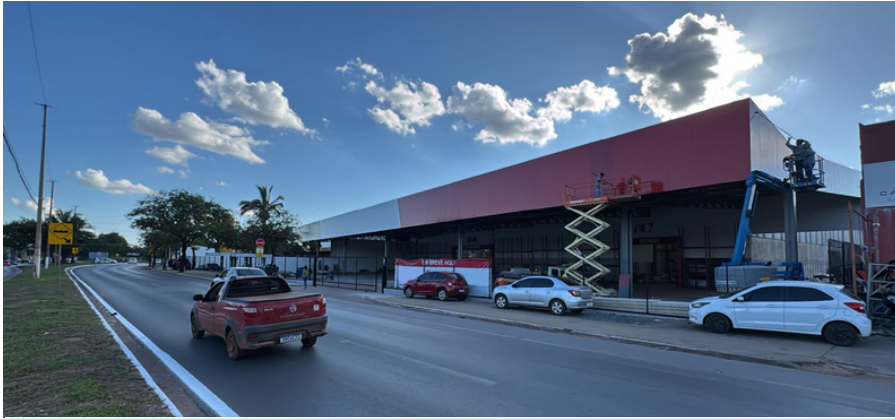
Fachada do Imóvel - Vista Externa
