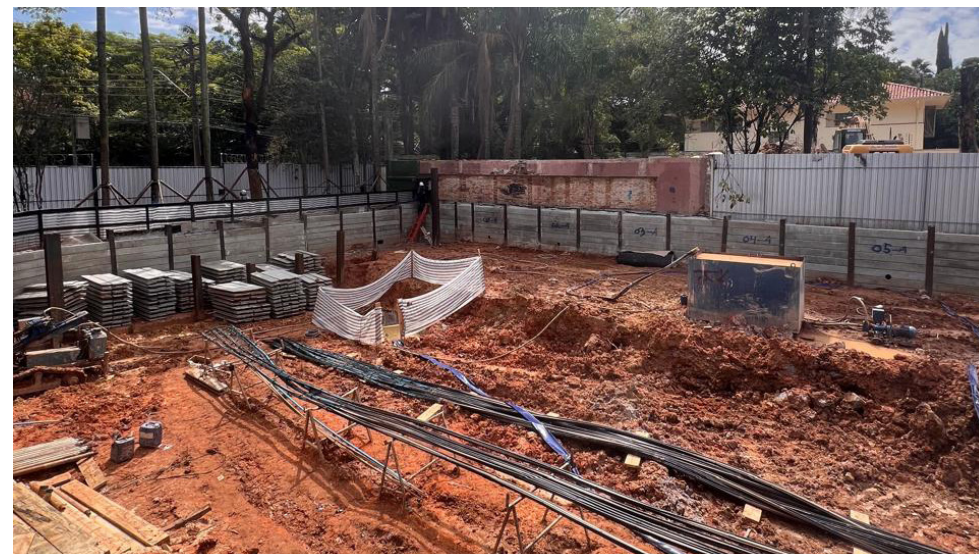
FOTO DA OBRA
