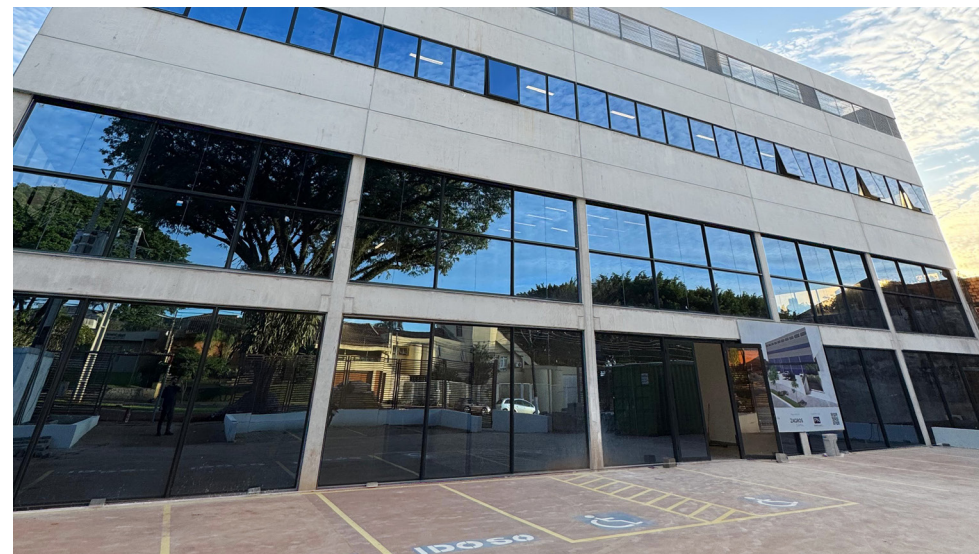
FOTO DA OBRA
