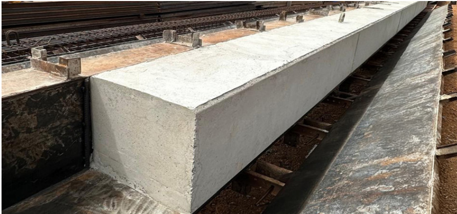
Início da Montagem dos Pilares
