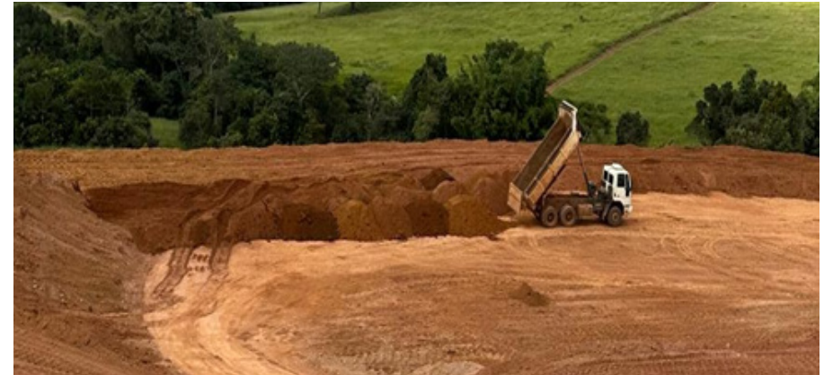
Contenção e Finalização de Terraplanagem Talude
