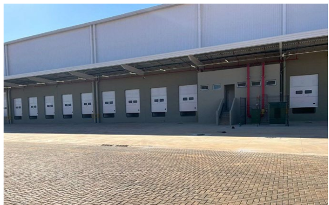
Docas e sanitários do galpão.
