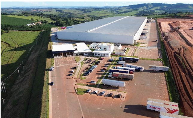
Imagem aérea do empreendimento.
