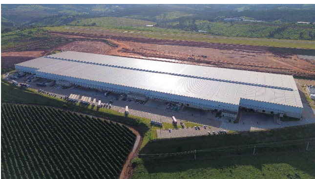
Docas e circulação do condomínio, com sinalização horizontal concluída.
