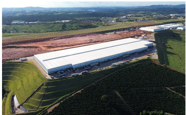
Imagem aérea do empreendimento.
