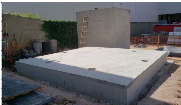
Fundação do reservatório e bacia de contenção do tanque diesel
