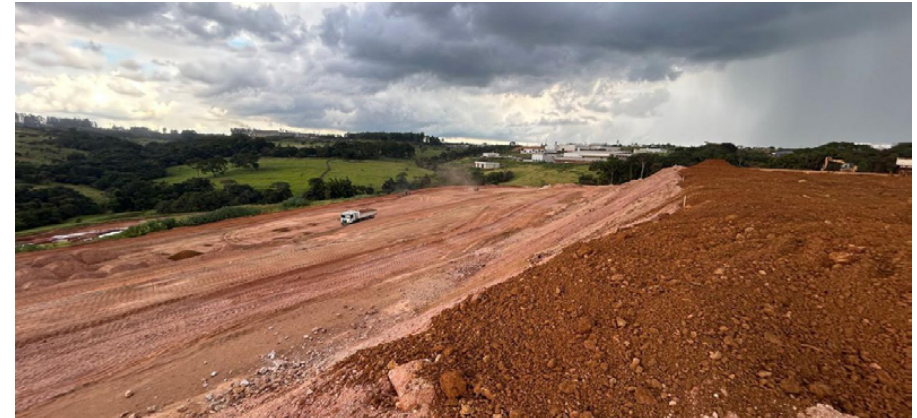
Encaixe Saia do Talude - Platô Galpão
