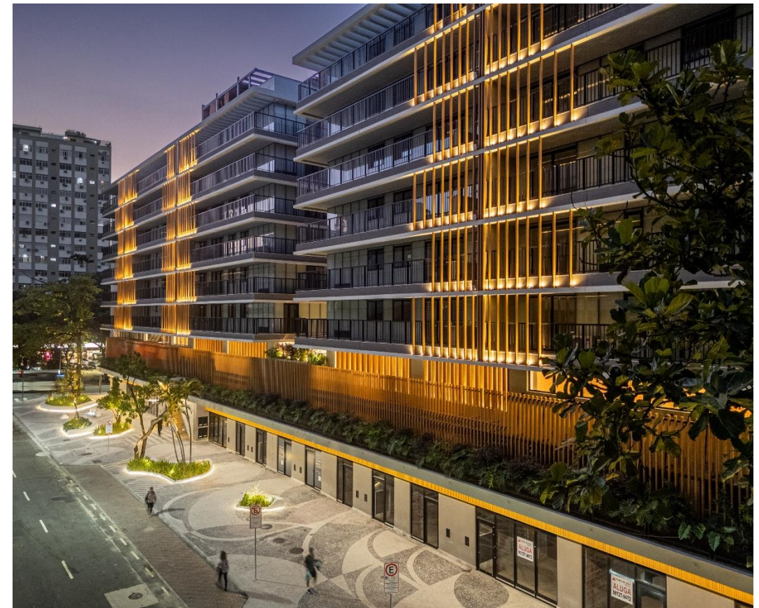
Fachada Essencia – Leblon
