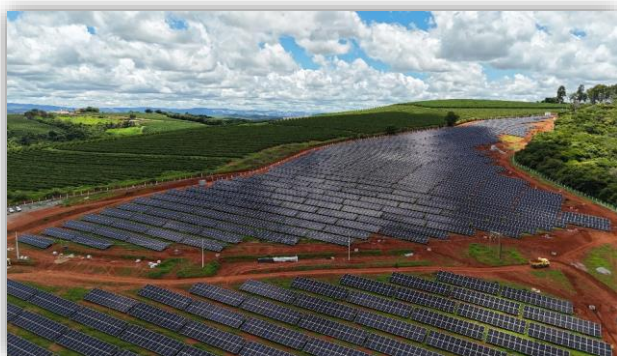
Obras UFV São Bento Abade.
