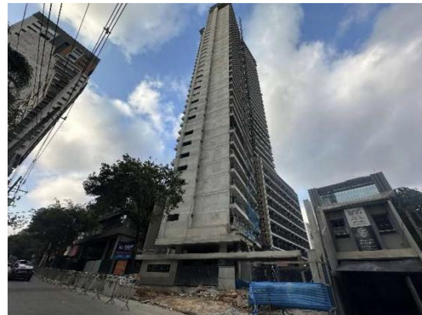
Foto da obra.
