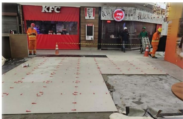
Instalação de porcelanato.
