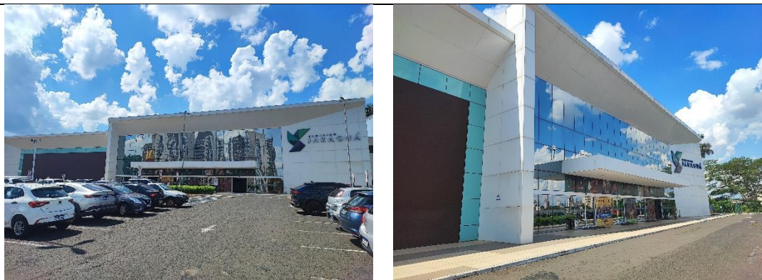
FOTOS DA FACHADA DO IMÓVEL
