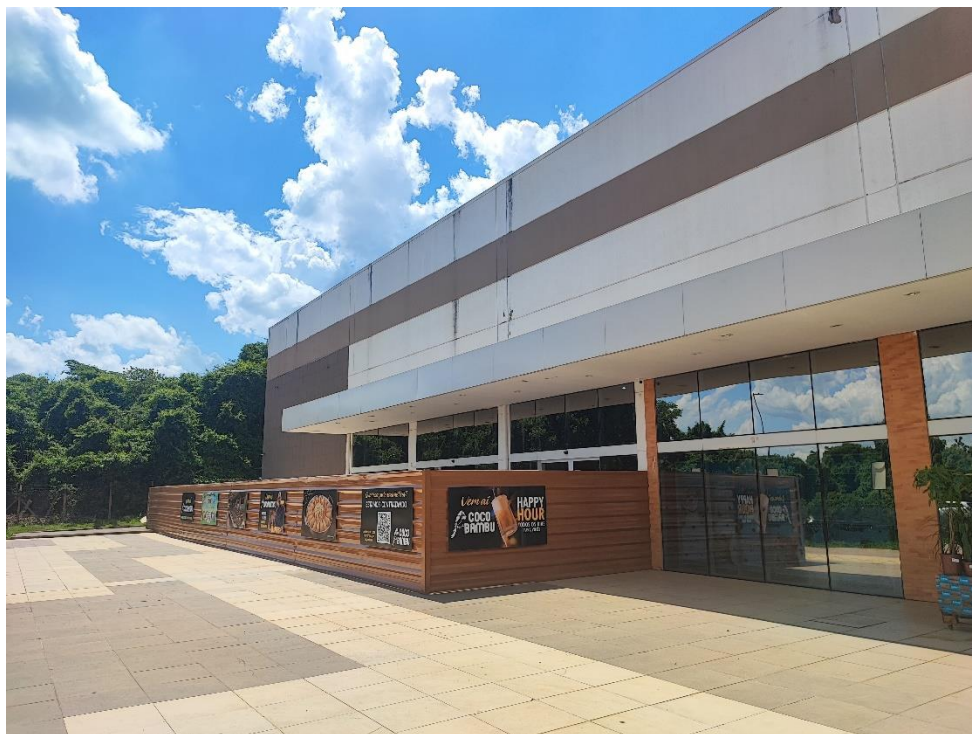
COCO BAMBU (EM OBRAS)
