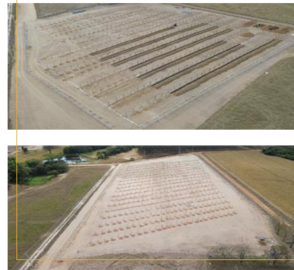
Usina NSF II – Cajuru - SP
