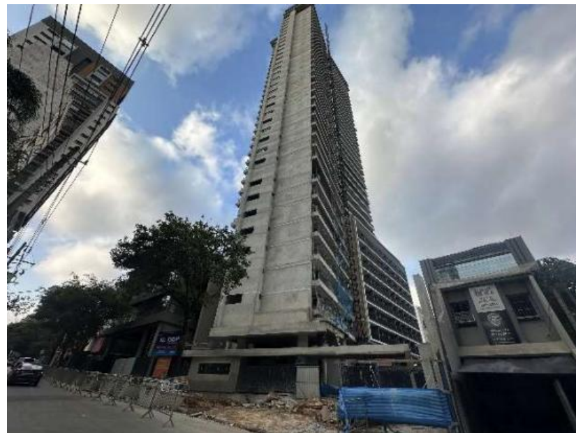
Foto da obra.
