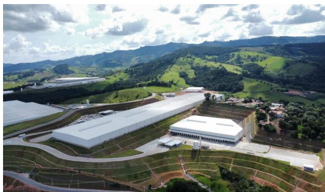
Execução de obras – Foto Panorâmica
