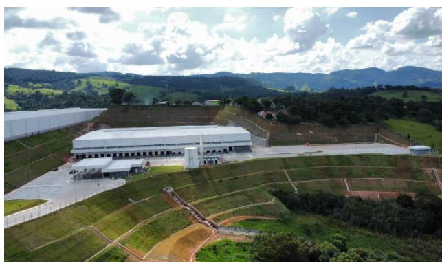
Execução de obras – Foto Panorâmica
