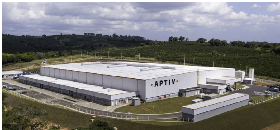
Vista Aérea do Galpão
