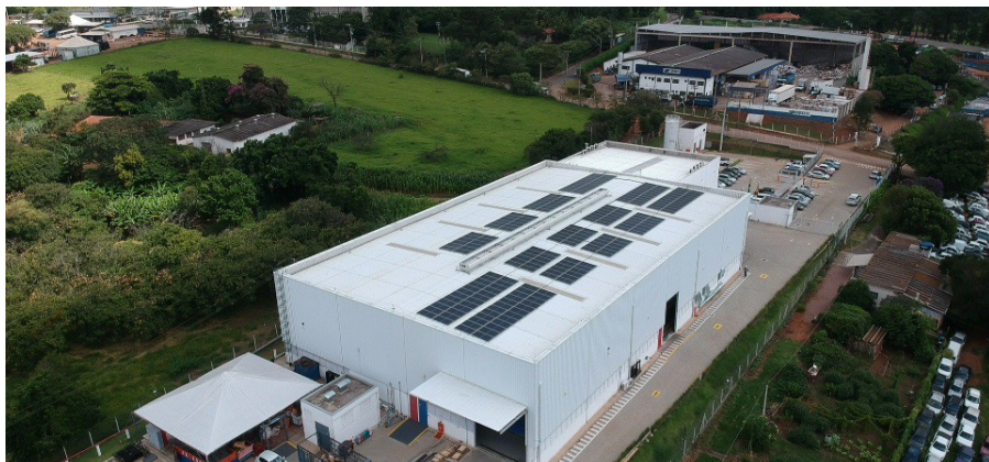
Vista Aérea do Galpão
