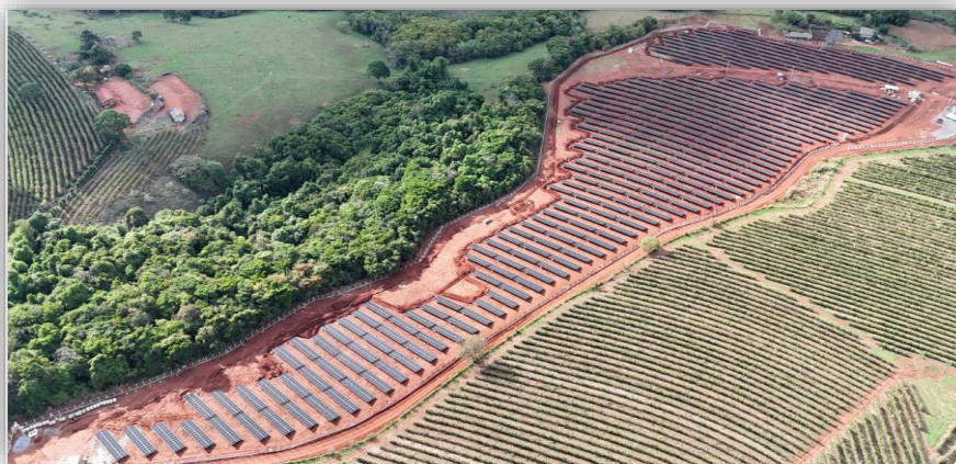
Obras UFV São Bento Abade.
