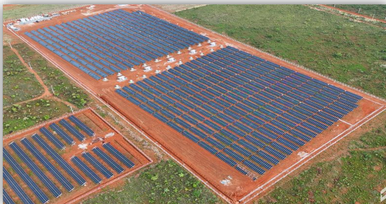
Obras da Ufv Mundo Melhor.
