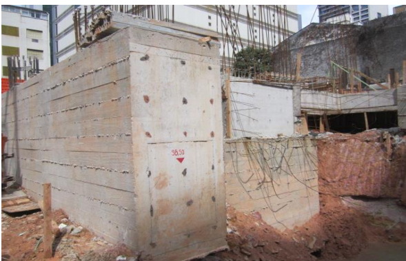
Blocos de Fundação – Torre 1
