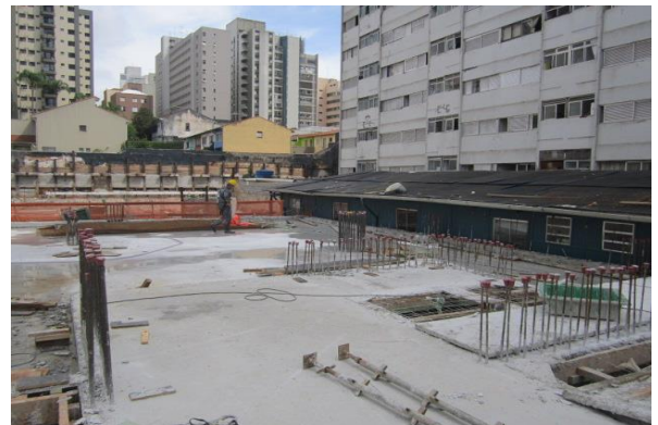
Piso da Laje – 2º pavimento Torre 2
