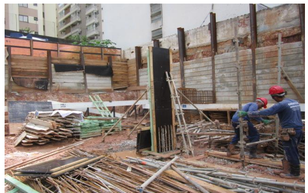
Forma para execução dos Pilares
